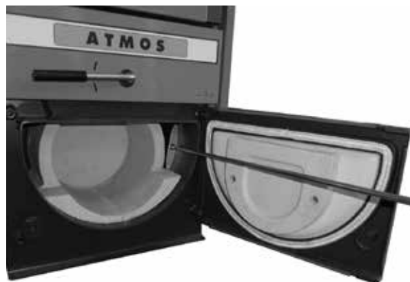
Otevřený spodní prostor kotle s kulovým prostorem a ukázkou vyhrabování popela pomocí pohrabáče z boků spalovací komory
