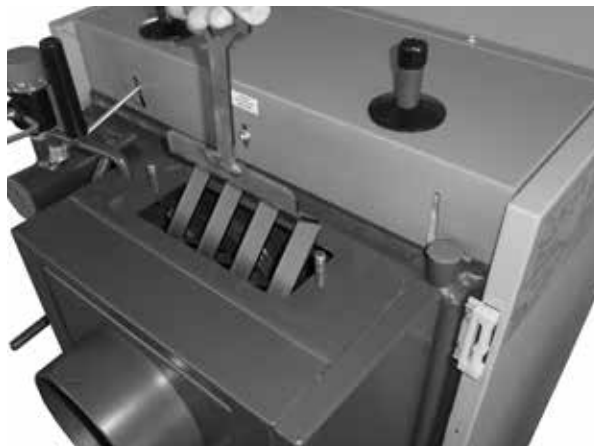
Ukázka vytažení brzdíče ze zadního kouřového kanálu při jeho čištění - pod vrchním víčkem (AC25S, AC45S)
