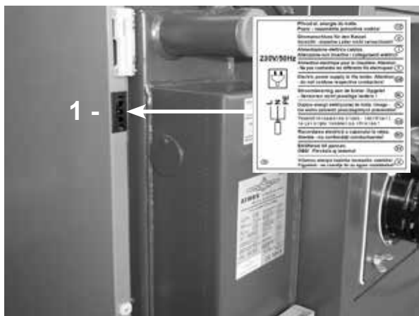
Konektor v pravé kapotě kotle
