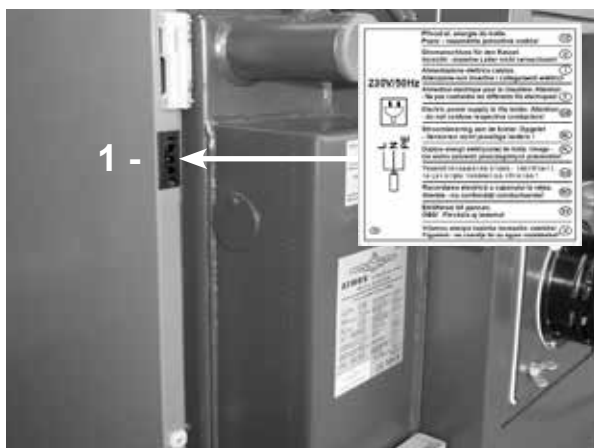
Konektor v pravé kapotě kotle
